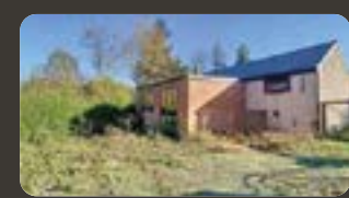
ROLY Maison d'environ 138m² au sol à l'état de gros oeuvre fermé. FO apd 80.000 € - Ss rés accept proprio
